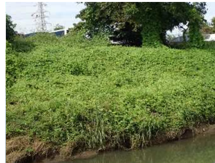
アレチウリに覆われた堤防（妙見橋）
