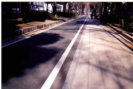
歩車分離された氷川参道。四季折々の草花やお気に入りのスポットを探しながら、ゆったりと歩けるようになりました。
