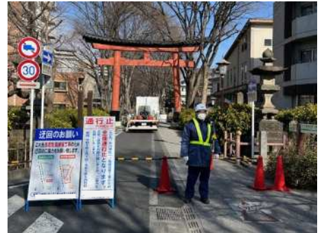
一の鳥居改修工事の様子
