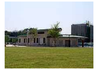
便所+備蓄倉庫
