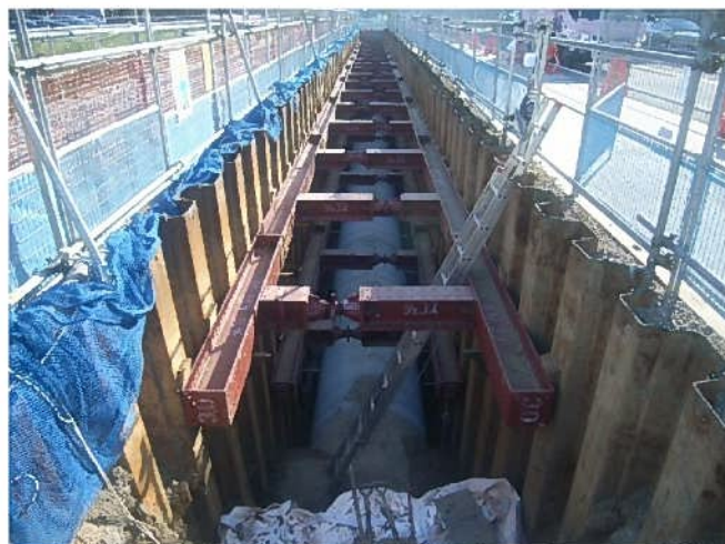
雨水管布設工事(施行状況)
