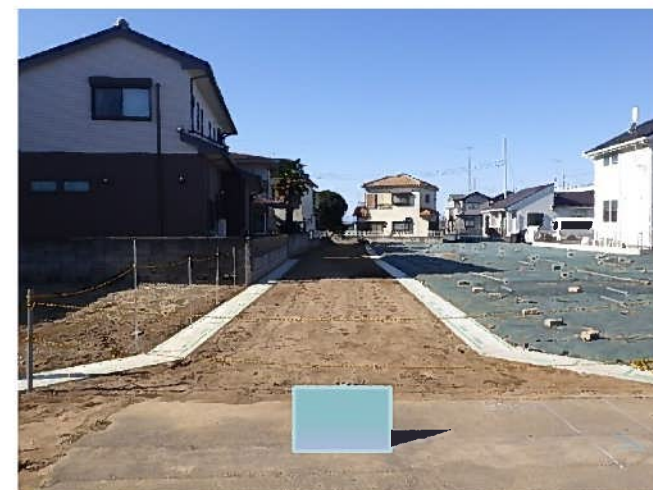
側溝布設工事(完成)
