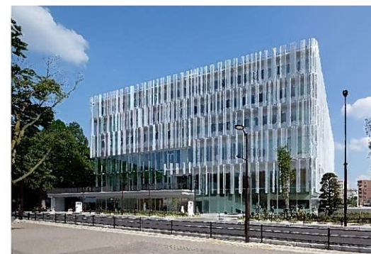
大宮区役所新庁舎
