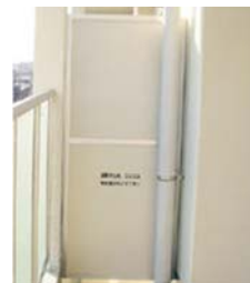
参考 改修後の隔て板
