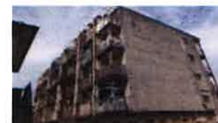
（建物の傷みが著しく外壁の剥落等が生じた事例）
