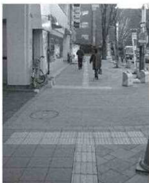
■車の乗り入れがある歩道部分の誘導用ブロックの敷設例
