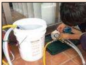
高圧洗浄の準備
