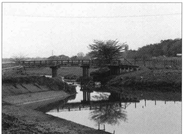
拡幅工事の進む芝川
