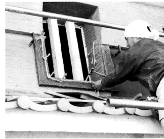
▲ 窓の額をつくる
