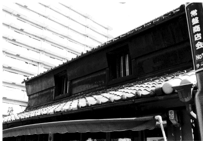
▲ ムシコ窓（解体前：旧綿貫家住宅）
