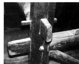
▲部材の接ぎ部分
