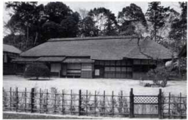
旧坂東家住宅（有形文化財・建造物）
