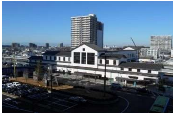
岩槻駅舎(H29.3 完成)
