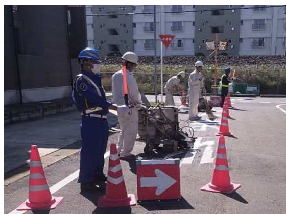
交通安全施設の修繕
