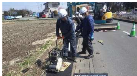
土木緊急修繕等事業
