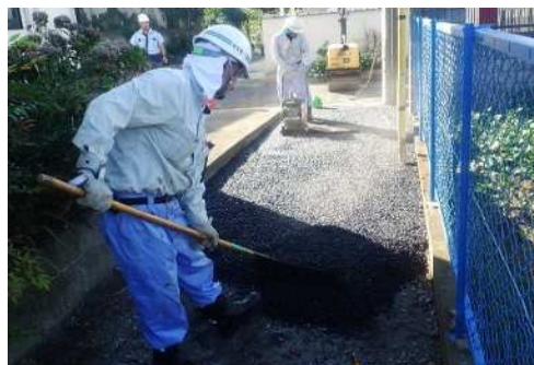
土木緊急修繕等事業
