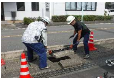
土木緊急修繕の様子
