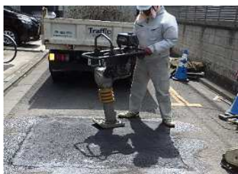
【道路緊急修繕】
