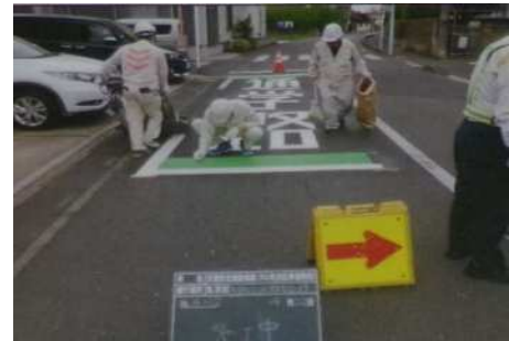
路面表示修繕
