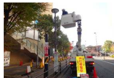
【交通安全施設修繕】
