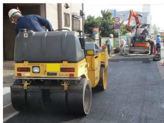
道路の緊急修繕
