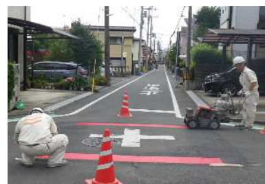
路面表示修繕の様子
