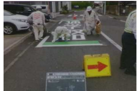
路面表示修繕
