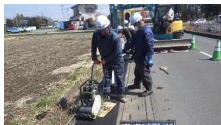
土木緊急修繕等事業
