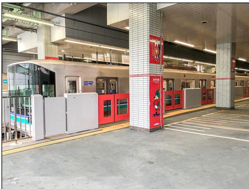
図 3-22 埼玉高速鉄道の浦和美園駅臨時ホームに設置されたホームドア
