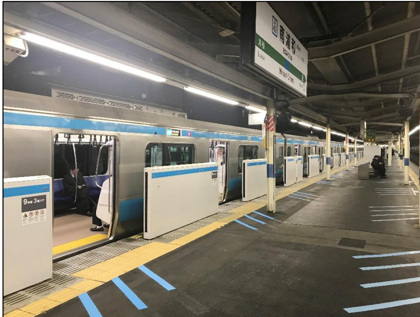
図 3-21 京浜東北線南浦和駅1番線(南行)に設置されたホームドア
