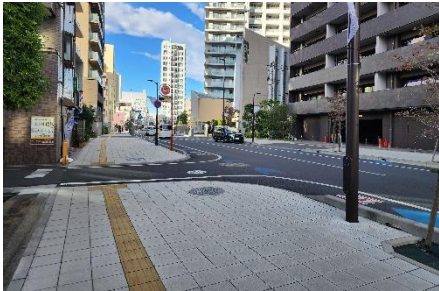
セミフラット構造の歩道
