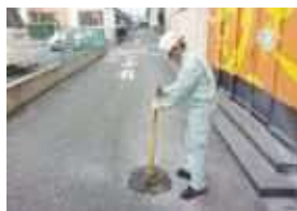
道路緊急修繕
