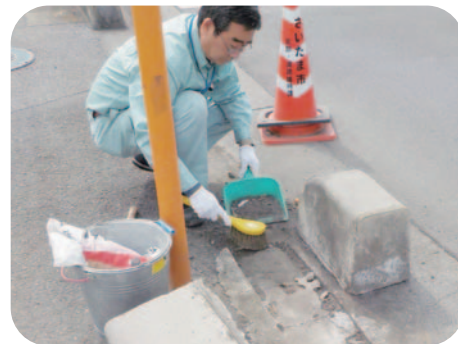
■土木緊急修繕
