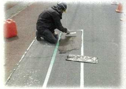
道路の緊急修繕
