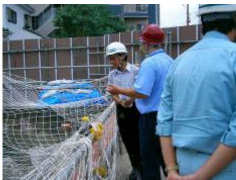
マレーシア研修員建設現場視察
