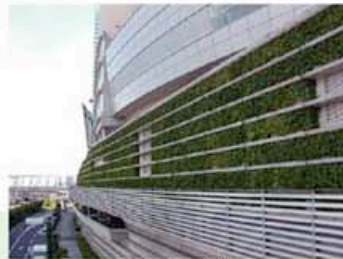
建物壁面の緑化 (さいたまスーパーアリーナ)
