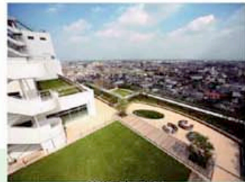
建物屋上の緑化 (コムナール)
