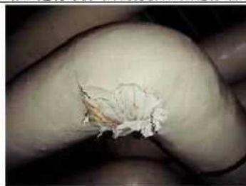
アスベスト含有配管保温材（配管）
