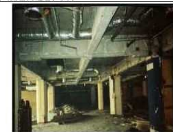
アスベスト含有けい酸カルシウム板第2種（梁）
