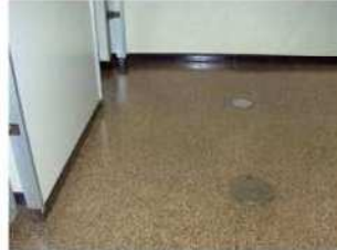
アスベスト含有ビニル床シート (床)
