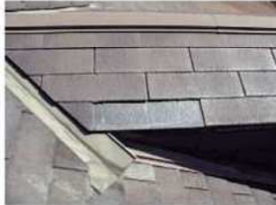
アスベスト含有住宅屋根用化粧用スレート(屋根)
