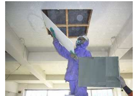
②建材の取り外し状況
