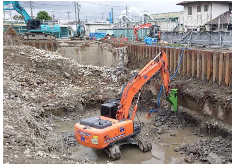
地下構造物解体工事施工状況 参考写真
