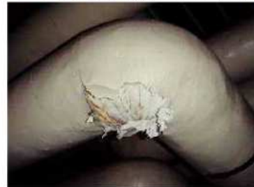
アスベスト含有配管保温材（配管）
