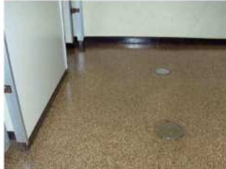
アスベスト含有ビニル床シート (床)
