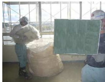
③廃材の袋詰め状況
