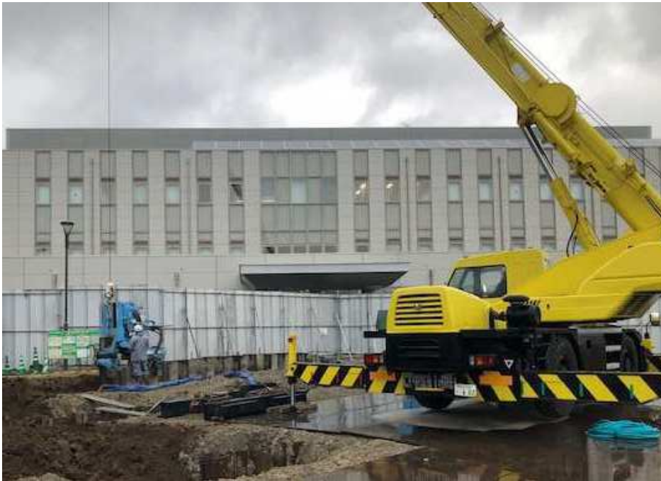
山留め工事施工状況 参考写真
