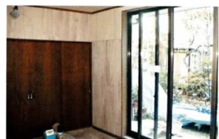
室内側に合板を張り、耐力壁をつくる
