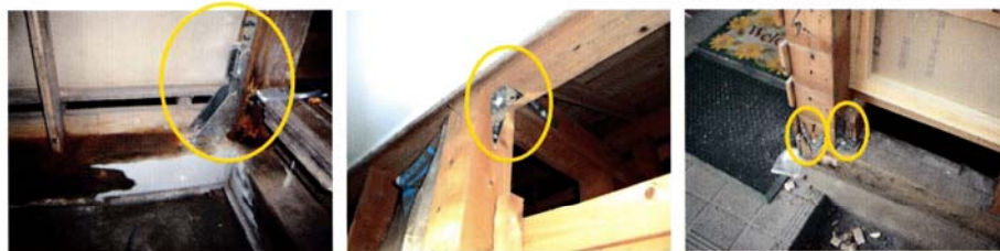
柱と梁・土台に金物を取り付け、地震時に引き抜けることを防止する
