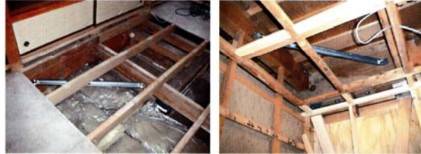
火打ち金物や合板で床組みを補強する
