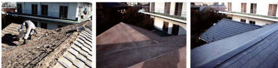
重い瓦を下ろし、下地をつくり、軽い屋根で葺く
