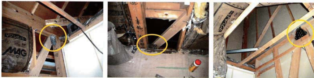
筋かい金物を取り付け、地震時にはずれることを防止する
