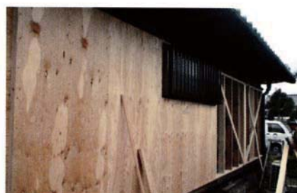
外壁側に合板を張り、耐力壁をつくる
