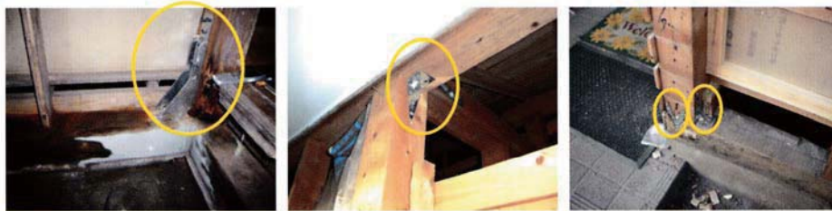
柱と梁・土台に金物を取り付け、地震時に引き抜けることを防止する
