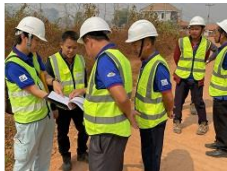
施工計画の確認状況
