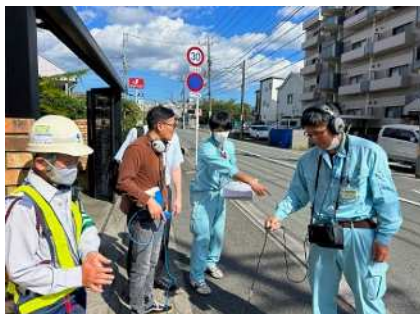
漏水探知に関する現場OJTの様子
