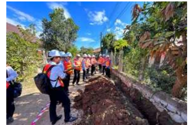
配水管布設現場視察 (草の根技術協力の成果確認)
