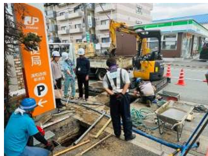
修繕施工に関する現場OJTの様子
