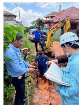
修繕施工現場における調査の様子
