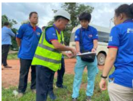
図面を基にした配水管布設状況の確認
