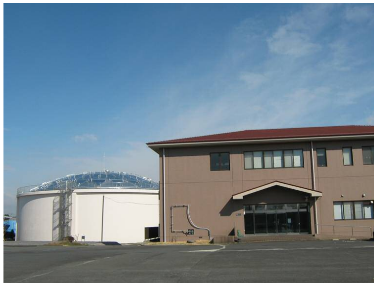
相野原配水場
