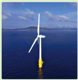
浮体式洋上風力発電 風車全景 (撮影: 西山芳一)
