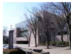
平成20年度にE S C O改修工事を実施したさいたま市文化センター
