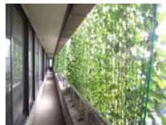
市役所本庁舎の緑のカーテン ▶
