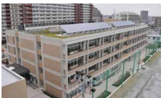
▲太陽光発電システム (つばさ小学校 30kW、H20導入)
