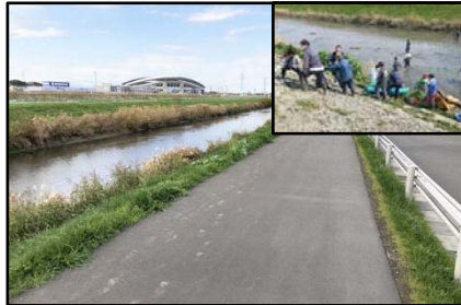
△綾瀬川遊歩道の整備および活用 地域の回遊性向上や住環境の整備だけでなく、地域で清掃も実施しています。
