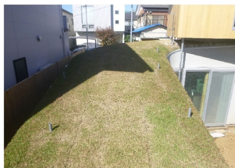
屋上緑化の様子
