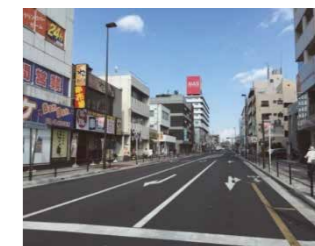
無電柱化整備後
