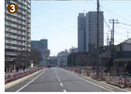
②南辻新曲輪線 東武野田線の線路の下を通過する都市計画道路「南辻新曲輪線(みなみつじしんくるわせん)」。鉄道と道路が立体で交差することで、より安全で円滑な交通環境が整備されました。 ③岩槻駅西口駅前通り線 岩槻駅西口地区では、駅西口の開設に合わせ、駅前交通広場や駅前通りの整備等を行っています。 ※②③の写真の撮影位置は土地区画整理事業区域外
