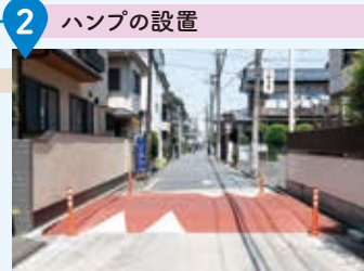
参道の東側の道路には、通行する車が減速するよう、道路の一部を隆起させたハンプを設置。
