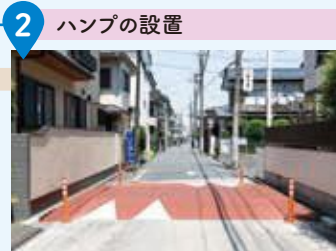
参道の東側の道路には、通行する車が減速するよう、道路の一部を隆起させたハンプを設置。
