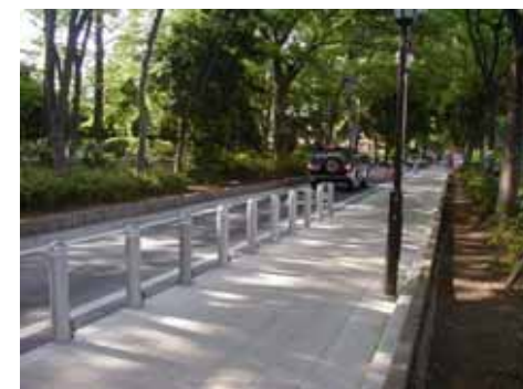
氷川参道歩車分離事業(一部施工済)
