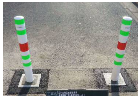
車止めの補修
