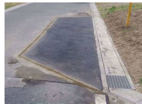
側溝、舗装の補修
