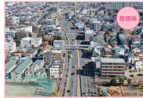
標準部の完成済み箇所 (中央区大戸3丁目付近)
