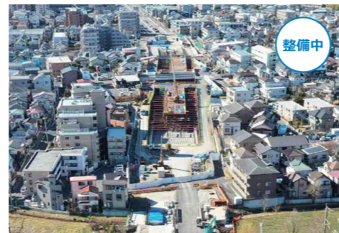
現在の状況 (桜区西堀9丁目付近)
