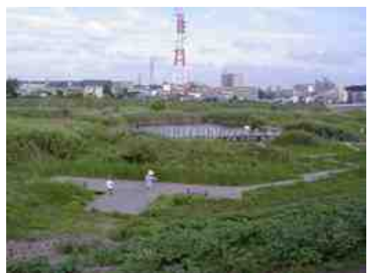
鴨川第一調節池(西区)
