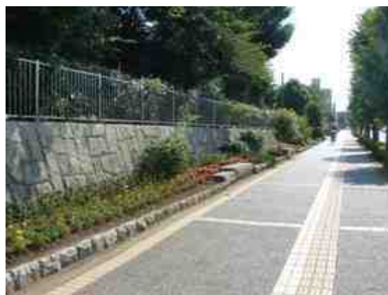
道に面した部分に花壇を設置した与野西中学校 (中央区)
