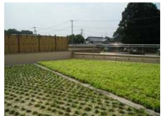
片柳コミュニティセンターの屋上緑化(見沼区)
