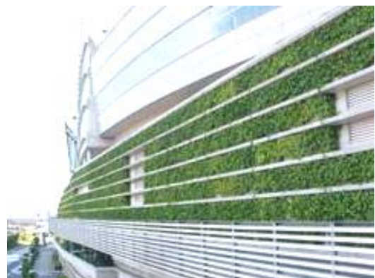
さいたまスーパーアリーナの壁面緑化(中央区)
