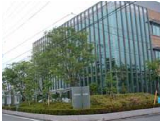
緑区役所の外周部の高木緑化
