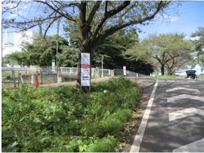
⑦米原橋南
