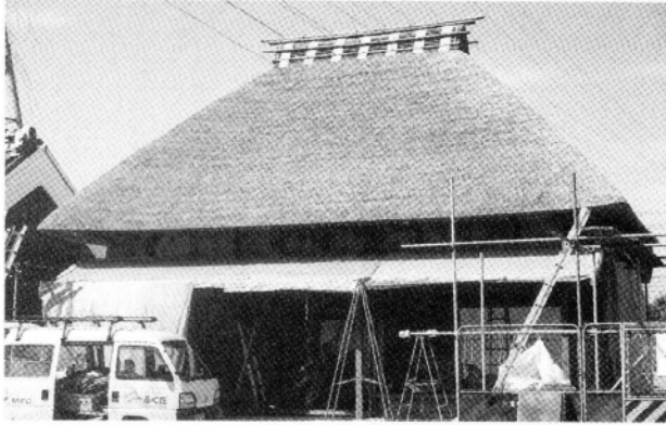
▲茅葺屋根の完成
