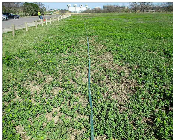
▲灌水チューブの設置
