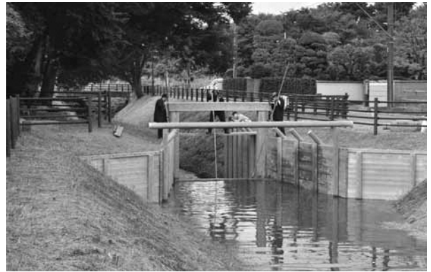
▲閘門開閉による水位調整の様子
