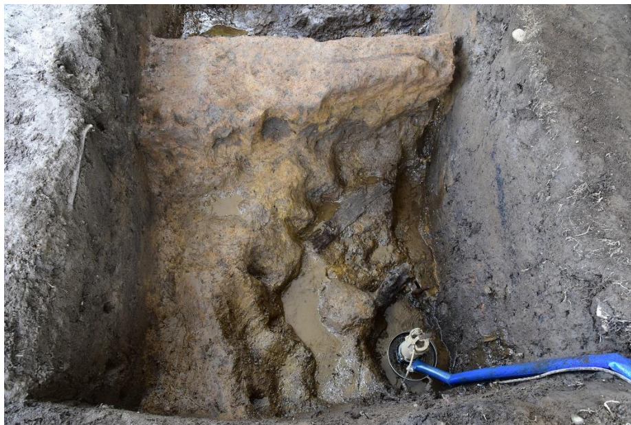
写真2 新しい掘り込みの完掘状況
